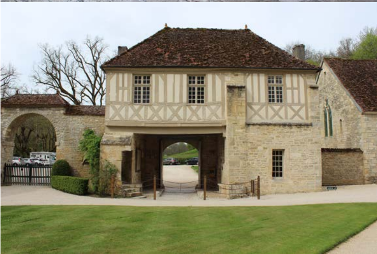
Nelle foto: chiostro, fucina e edificio di ingresso di Fontenay
